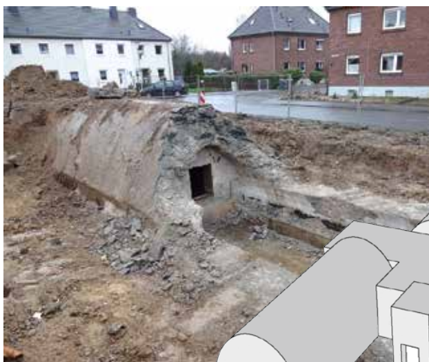
29.01.2013: Abriss des Stollentiefbunkers
