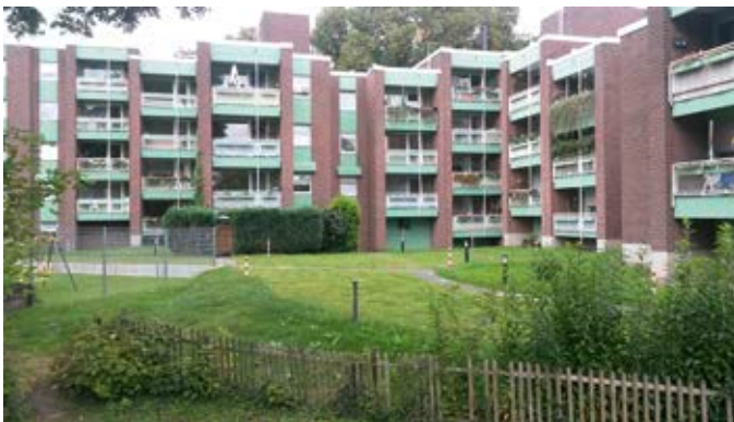
Rheydter Straße, Rückansicht einschl. Feuerwehrezufahrt
