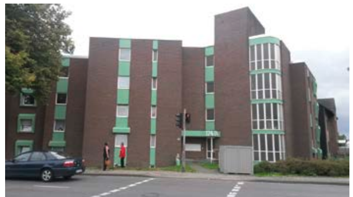
Rheydter Straße, Ansicht von der Düsseldorfer Straße
