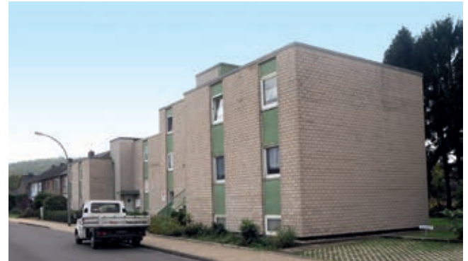
Sanierungsobjekt Herkenbuscher Weg im aktuellen Zustand
